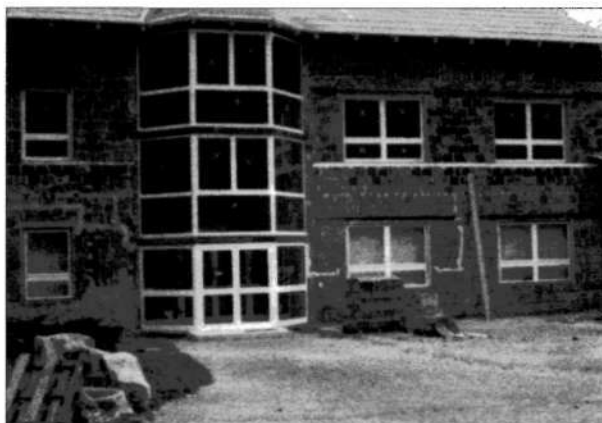
Рис 1.4. Строительство собственных производственных и административных помещений
